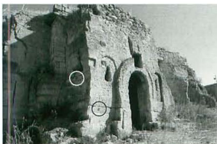
Fig. 6 壁面に貼られた位置合わせ用ターゲットシール
