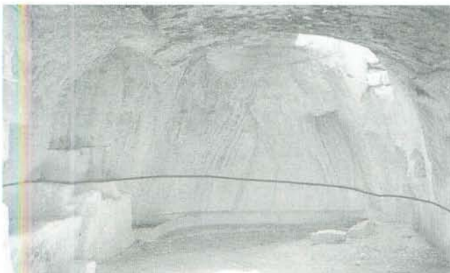
Fig. k-17 サン・ヴィート・ヴェッキオ教会における地層の境界線
