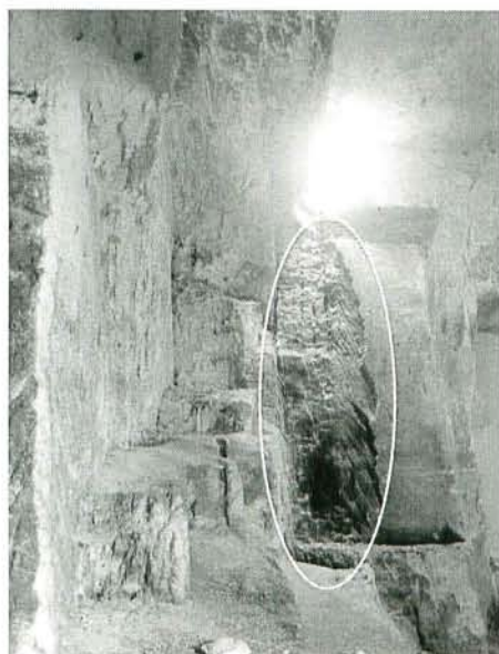
Fig.10 後陣壁左側 (聖ニコラウス画面) の掘削痕B
