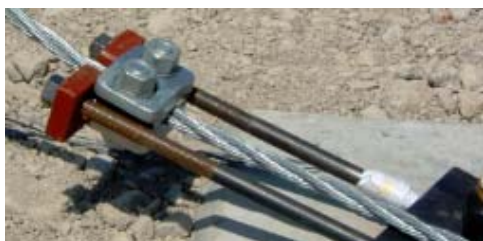
写真2 緩衝装置(上:クリップ型, 下:金具型)
