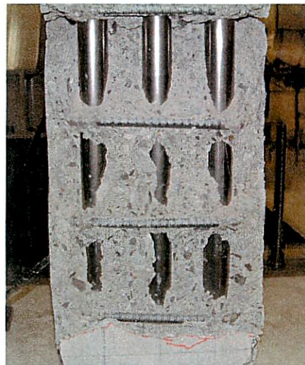
写真 3.17(1) 鋼管表面 (T27N10C)
