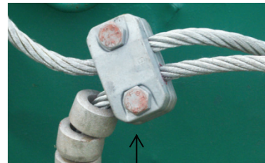
図-3(a) U型緩衝装置写真と作動イメージ
