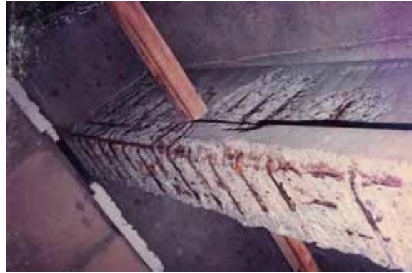
(b) コンクリート浮き部の除去後 (1982.11)
