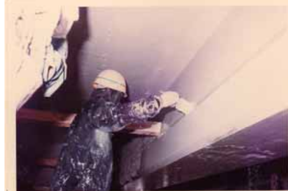
(d) 断面修復後のライニング状況 (1982.11)
