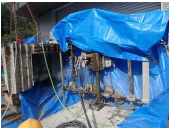
(a) 部材の切断状況
