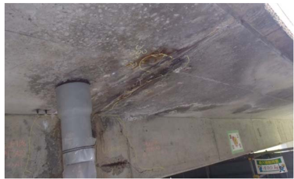
(b) 張出部の損傷状況
