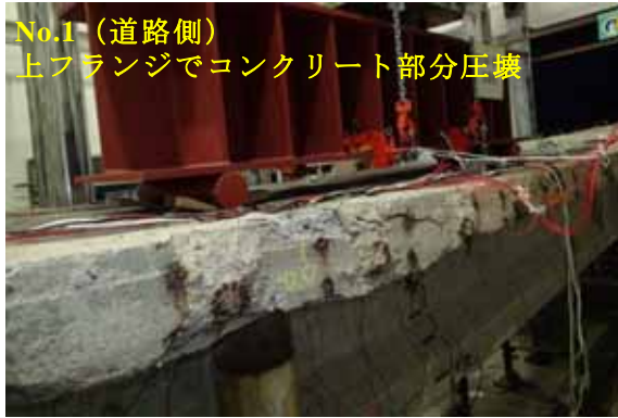
(a) No.1 上フランジの損傷状況
