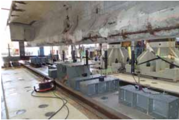
(a) 変位計の設置状況（主桁たわみ）
