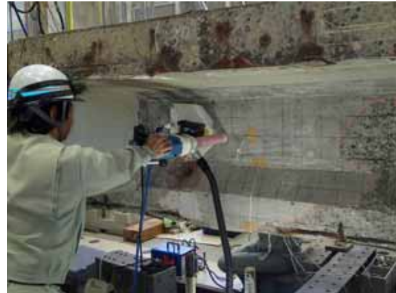
(b) コアカッターによる切り込み
