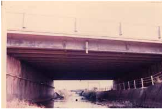
(a) 補修工事前の全景 (1982.11)
