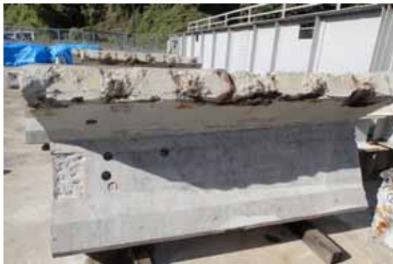
(a) 部材の切断状況
