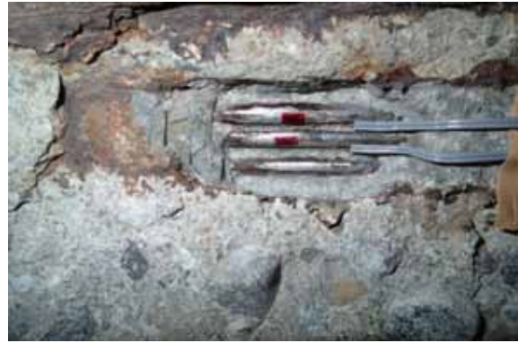
(b) ひずみゲージの設置状況（PC鋼材）
