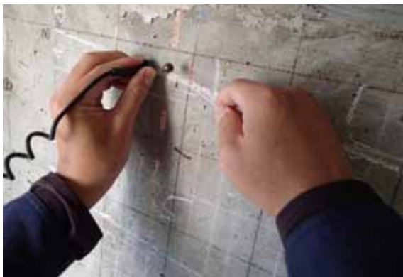
(a) 衝撃弾性波による非破壊調査状況
