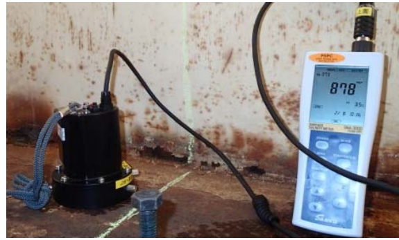
(b) 下フランジ素地調整の状況
