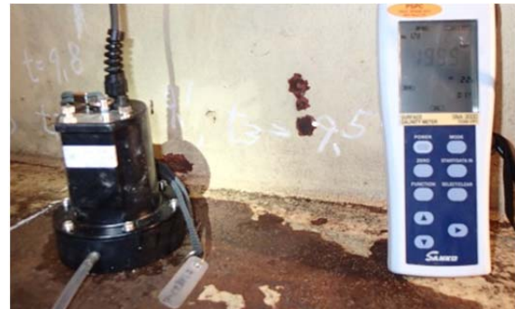
(b) 下フランジ素地調整の状況
