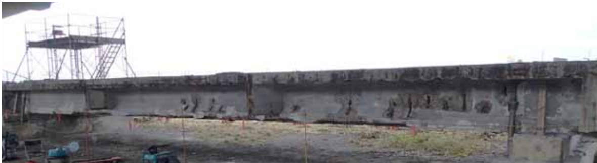
(e) ライニングおよび浮き部除去後の撤去した PCT 桁の屋外暴露状況 (2014.10)
