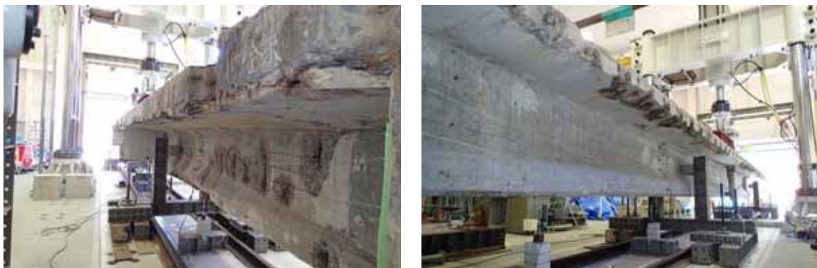
(a) 中分側の損傷状況
