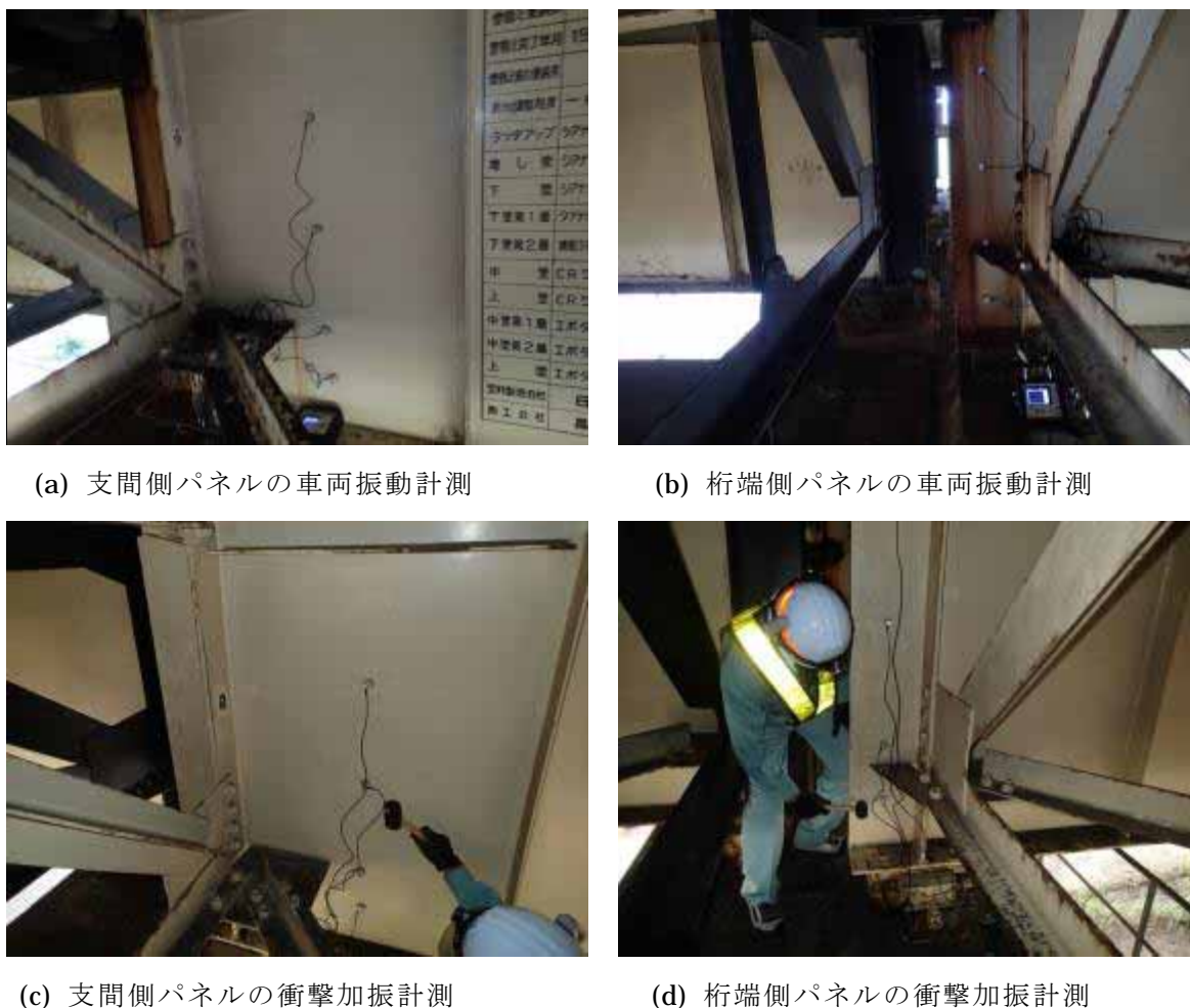
写真 4.4.2 鋼桁端部の振動計測の状況
