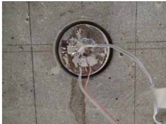
(c) コアカッターによる切込み後
