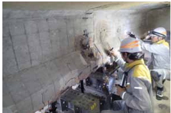
(d) 外観調査（載荷試験時）
