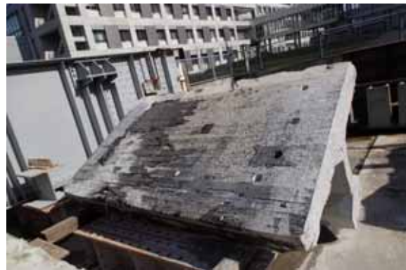
(b) 部材の切断面の状況
