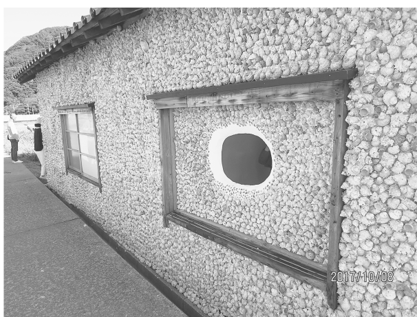
○大谷地区 赤神の小屋 村尾かずこ<サザエハウス>
