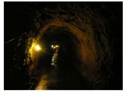
写真 1 トンネル内部
