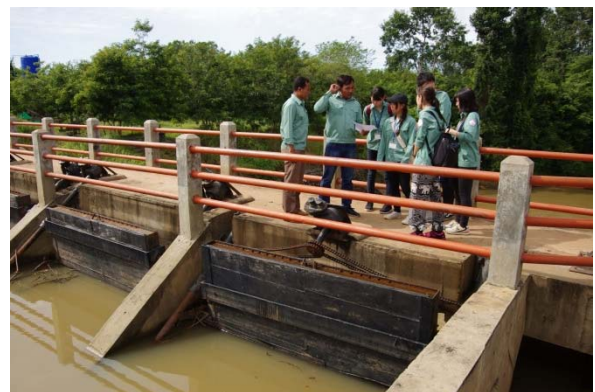
公団職員との水門の開閉検査
