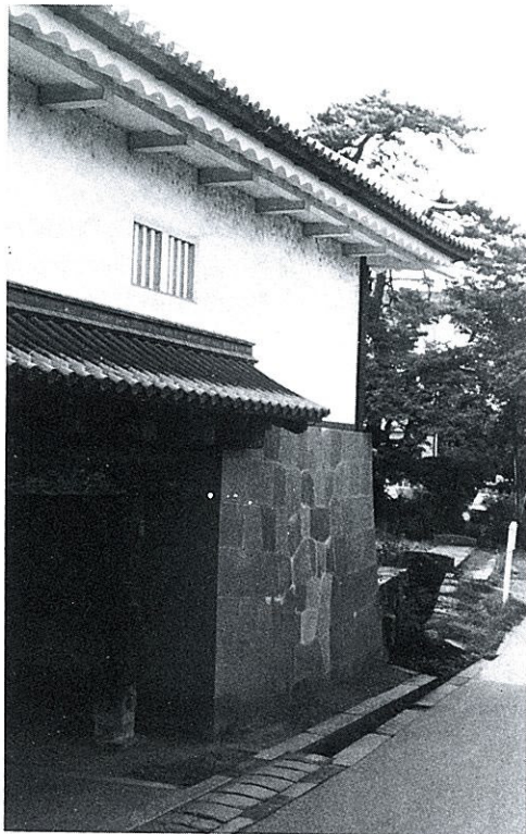
Fig. 2. 石川門出口（地点10）屋根は鉛瓦葺きである。前方に排水溝と排水口およびシダ植物の群生が見られる。
