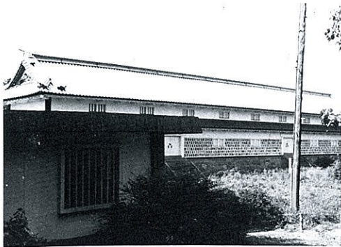
Fig. 5. 三十間長屋 (地点3) 屋根は全て鉛瓦で鉛白のごとく美しい白色に変色している。手前が植物園の管理室で、その向うに石段が二ヶ所見られる。
