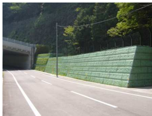
写真 1-6 落石防護土堤（補強土壁）
