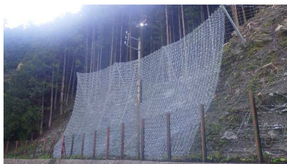
写真 1-5 ポケット式落石防護網
