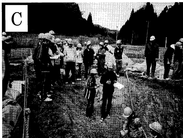
C 2007.4.19. 石川県輪島市中野屋 トレンチ調査現場 (40-110 cpm)
