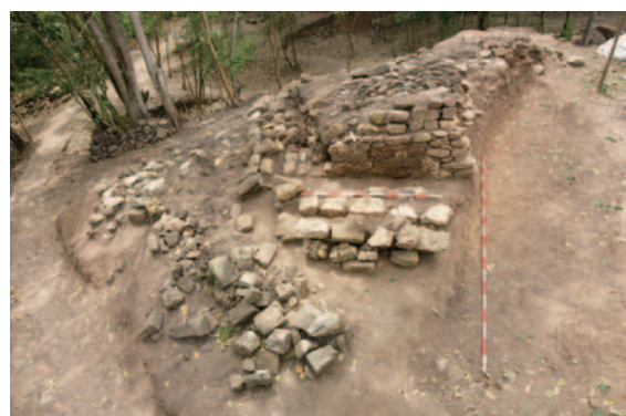
Foto 49: Dos muros frontales de diferente etapa después de la excavación. El primer muro está deslizado hacia el frente (Foto: Hiroyuki Ikarashi)
