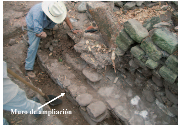
Foto 26: Trabajo de descubrimiento del basamento inferior en la parte norte de la Estructura 9L-102-1ª Fase
