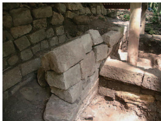
Foto 14: Muro de contención este y la moldura del cuarto del anexo este (ambos de la Etapa I)
