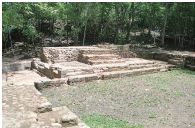
d Estructura 9L-102 después de la restauración
