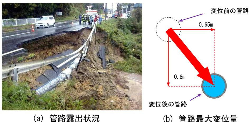
図 4-10 盛土崩壊後の管路状況
