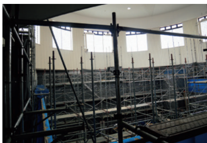
中央図書館特定天井耐震改修工事の様子
