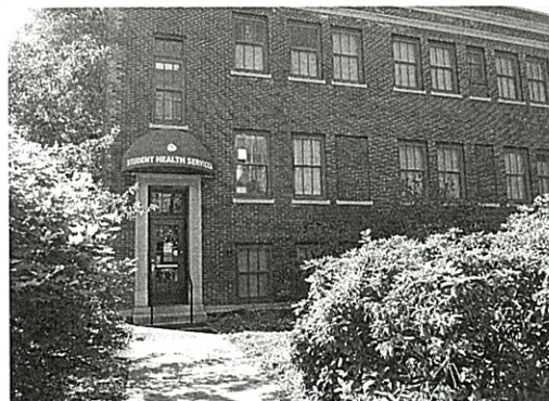
図 2 SHS 入口 2 (SHS・1 階)
