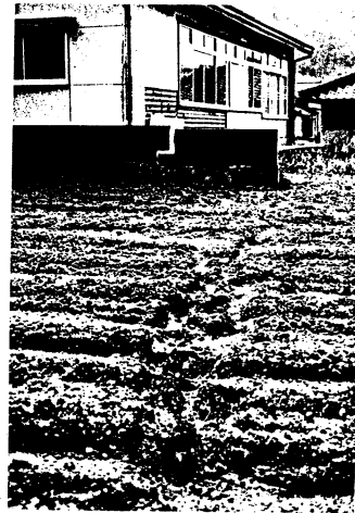
写真6 地盤の側方流動による畑地の亀裂と住家の被害（川浦町）
