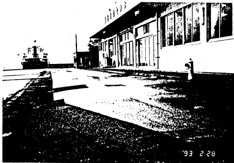
写真3 飯田港フェリー埠頭の沈下（飯田町）
