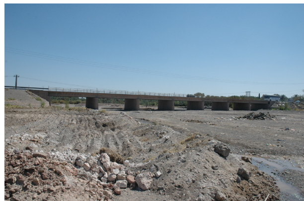
写真 4 観測点4：弾性波探査実施地点(Bridge 3)
