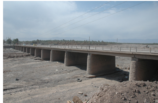
写真 2 観測点2: 弾性波探査実施地点(Bridge 1)
