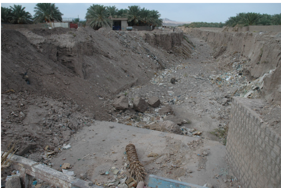
写真 3 観測点3：弾性波探査実施地点(Bridge 2)
