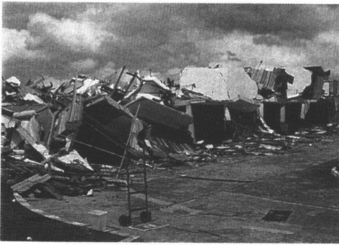
写真-1 竹筋泥壁工法, 焼成煉瓦による無補強組積工法による建物(提供:E.Rodriguez grandos)
