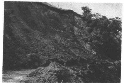
写真-5 斜面崩壊による崩土が道路を覆った現場
