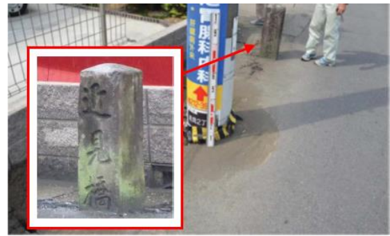
写真-4 近見橋の親柱
