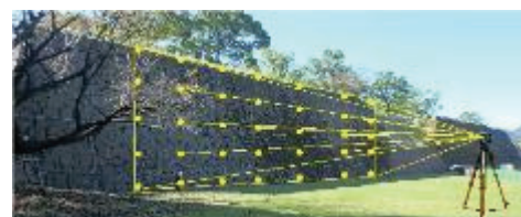
図-12 3Dレーザスキャナの測定イメージ
