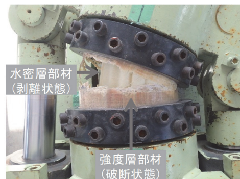
図-25 No.4 水密層部材剥離状況 ( 22.5^\circ , 突合せ部外面)
