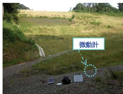
写真-2 盛土法尻での常時微動計測状況(縦-21での例)
