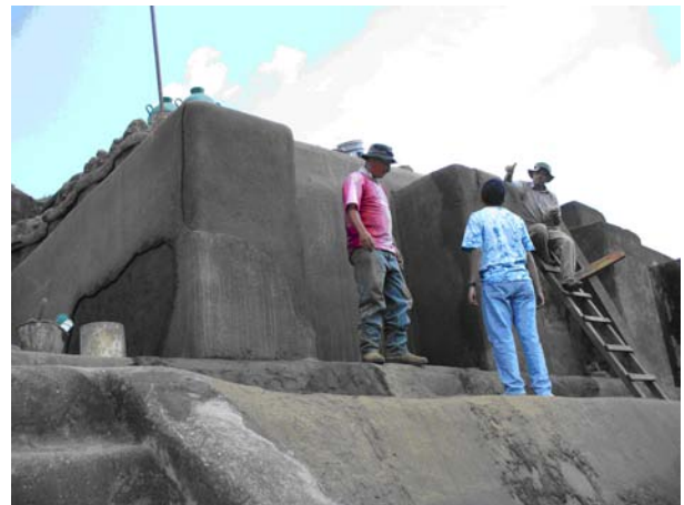
図 8-2. 修復作業風景
