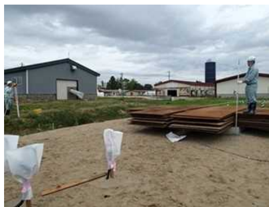
(b) 沈下量計測状況
