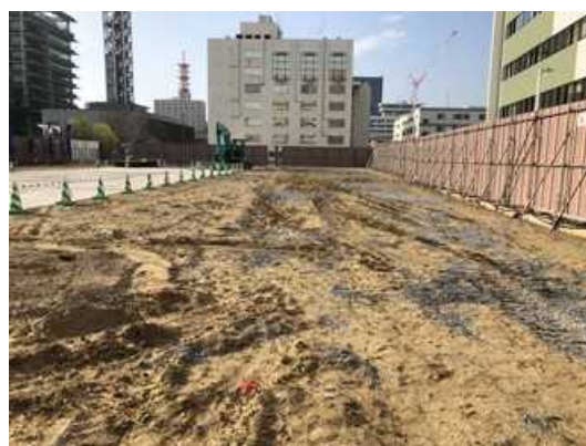
(b) 丸太打設後
