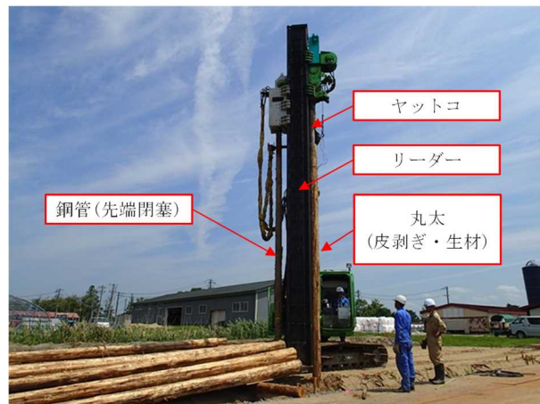
写真-2.4 丸太の打設状況
