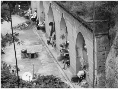
写真9. 延安清涼山にある窯洞
