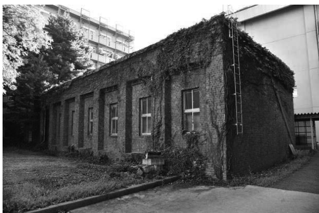
図4 医学類解剖標本庫 現況写真
