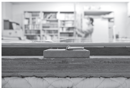
図29 新規吊り金具と土台
