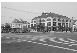
写真25 地下鉄9号線松江新城駅
