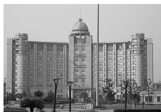
写真26 松江区政府庁舎
