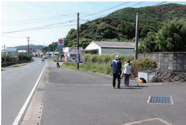
図 14 田ノ江窯跡測量風景（レベル測量）
