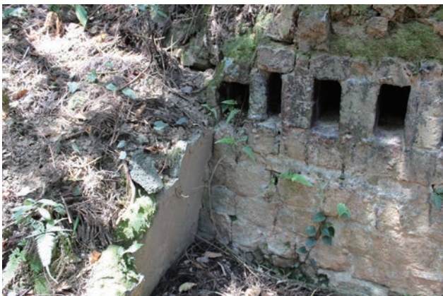
図 22 田ノ江窯跡第1室西側隅部
