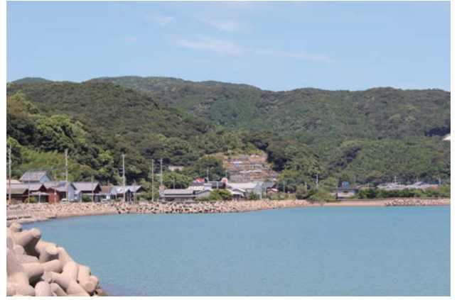
図 11 田ノ江窯跡遠景（写真中央左手）
