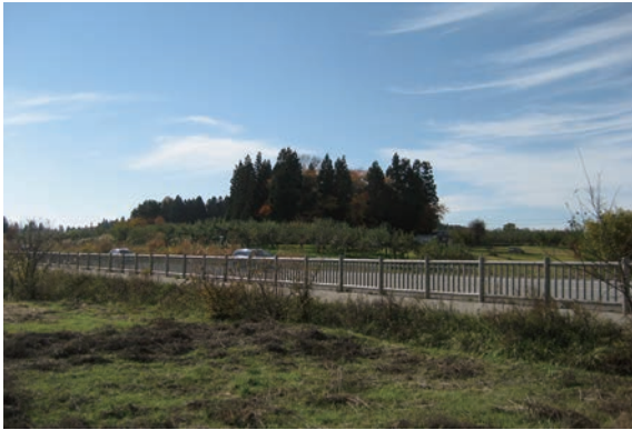
写真4 高屋敷館遺跡からみた方形区画地点
