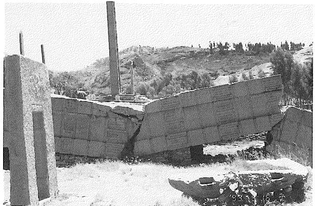
写真3 倒壊した最長のステレ
