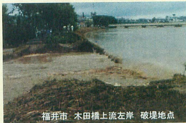
写真-1 足羽川破堤地点の流況 4)
