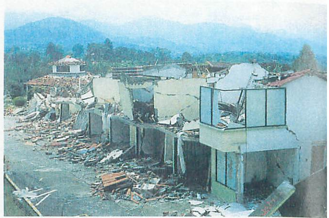
写真-3 屋根と外壁が倒壊した住宅(提供: E. Rodriguez Grandos)
