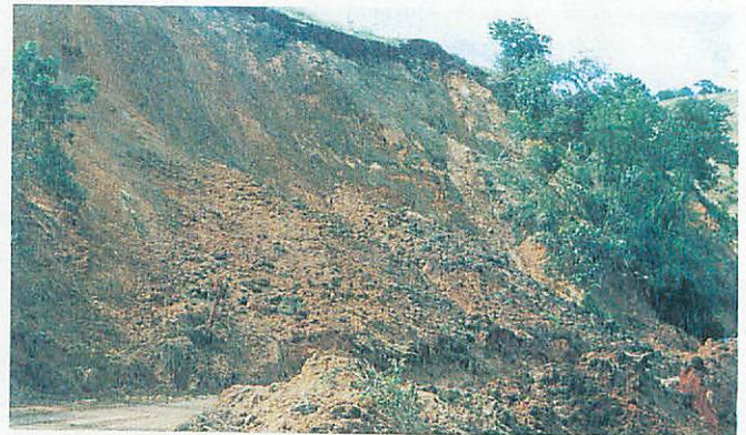
写真-2 斜面崩壊による崩土が道路を覆った現場（提供：E. Rodriguez Grandos）
