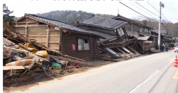
写真-1 輪島市門前町道下地区の木造家屋の倒壊
