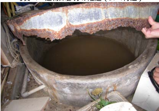
写真-5 井戸の地下水位状況 (Bv-1付近)
