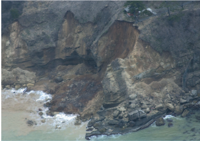
写真-2 ヤセの断崖の先端の崩落
