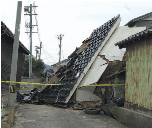
写真-7 倒壊した木造住宅(輪島市門前町道下)
