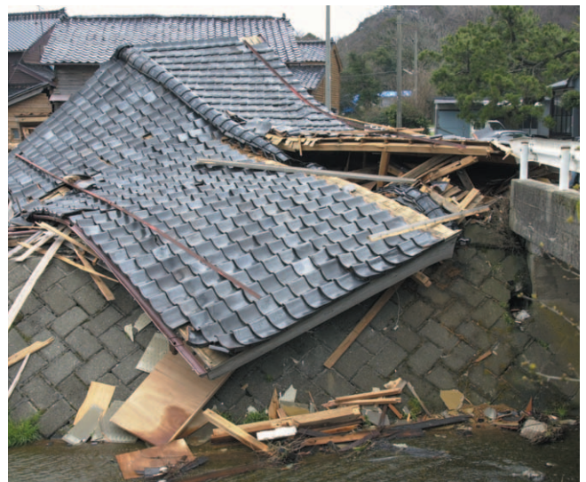
写真-6 道路を塞いで倒壊した土蔵(輪島市門前町道下)
