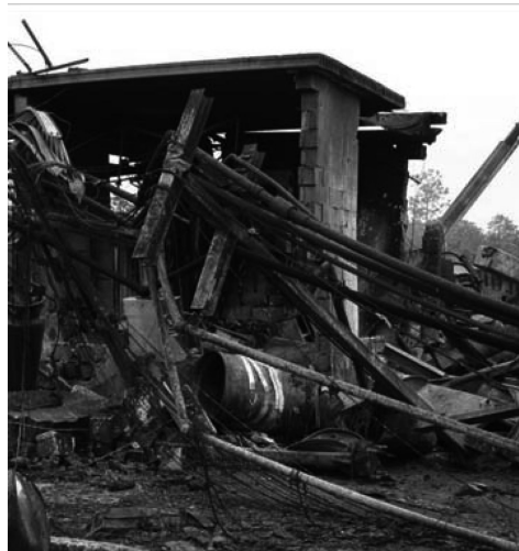
写真4 化学プラントの爆発事故で崩壊した建物
