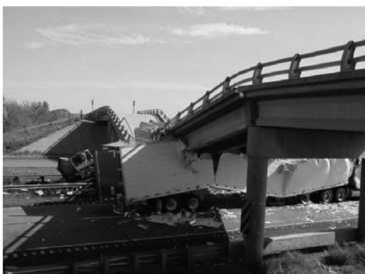
写真1 大型車両の衝突により崩壊した橋梁
