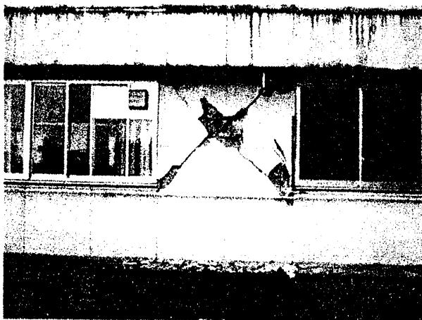
写真5 中条病院における病棟のせん断亀裂 (1967年建築)
