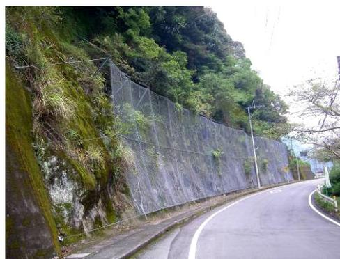
写真-1 ポケット式落石防護網
