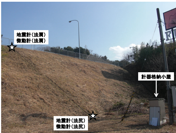
写真-2 対象盛土での地震計/微動計の設置
